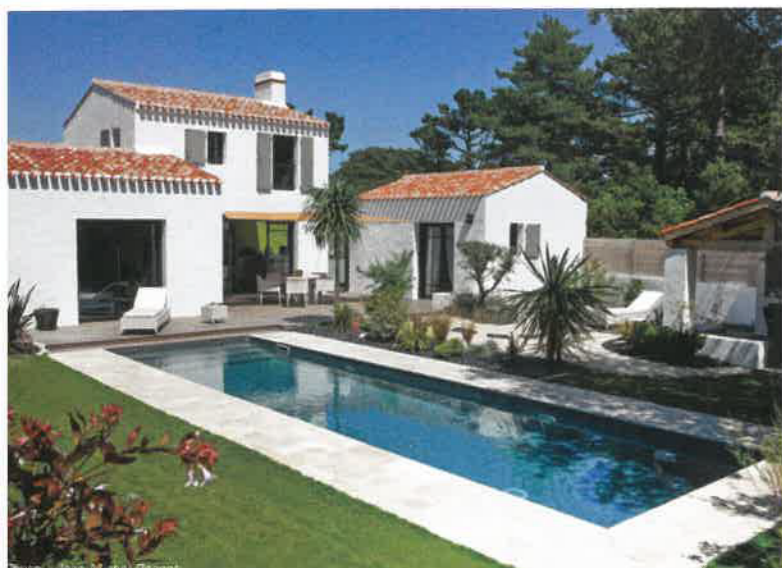
Photo : Jean-Luc Petit Piscine à panneaux béton modulaires de 10 m par 3 m - fond de 1,20 m à 1,60 m - revêtement liner 75/100 ème gris foncé - filtration à cartouches et désinfection au sel - volet immergé Smartcover ® .
